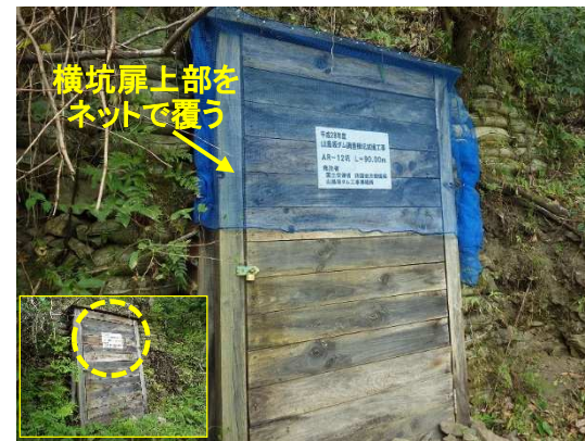
横坑扉上部の補修
