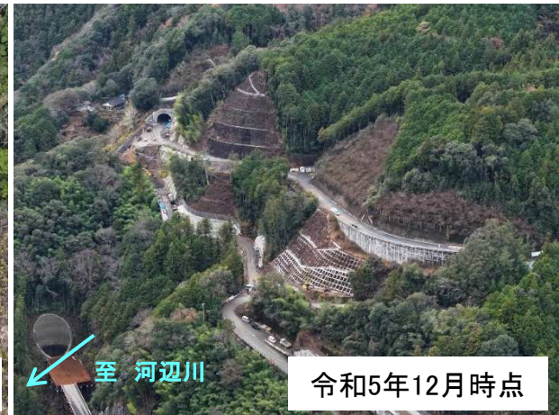
④付替県道工事(下敷水地区)
