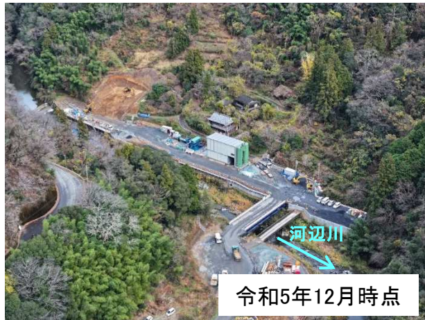
②工事用道路工事(京造地区)
