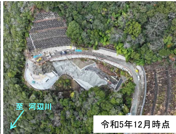
③工事用道路工事(見の越地区)
