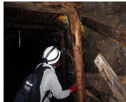
横坑内部の確認
