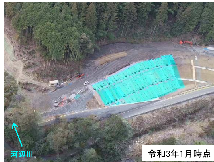
付替県道工事(椽の木瀬地区)
