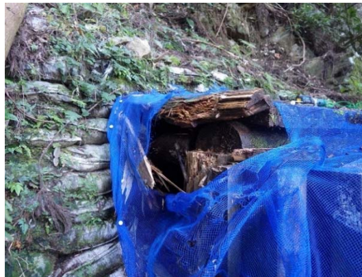
支障箇所 の状況(11月) TG-1(原石山)
