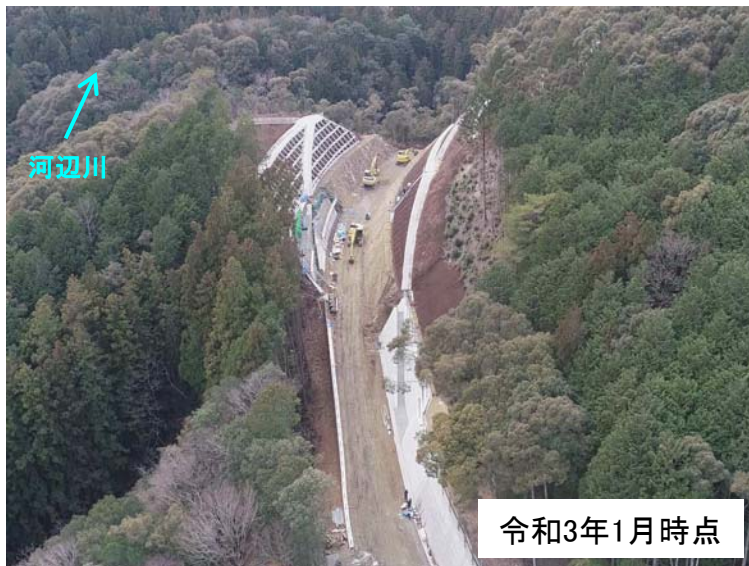
付替県道工事(菟野尾地区)
