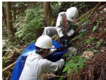
横坑扉の閉塞作業
