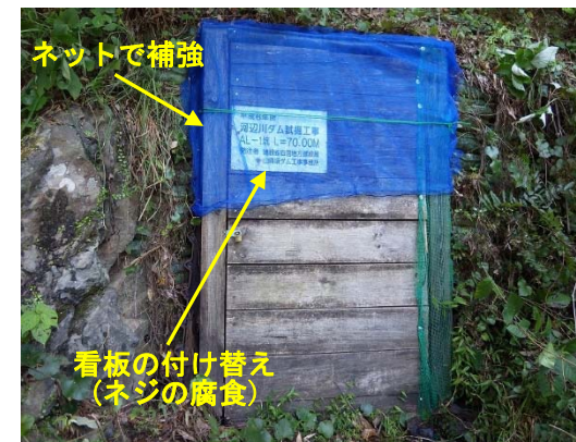
横坑扉上部全体をネットで覆う AL-1(ダムサイト左岸)
