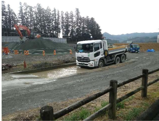
建設発生土処理場出口 でのタイヤ洗浄
