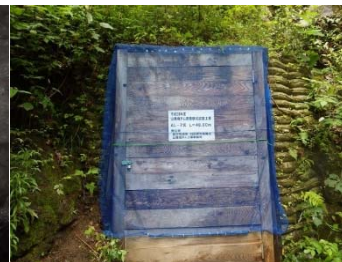
横坑入口の閉塞 状況(AL-7)
