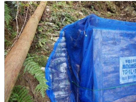
修復後の状況(11月)
