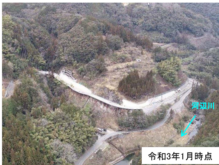
工事用道路工事(下敷水地区)
