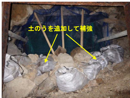
木杭の基礎となる土のうを追加 AR-5(ダムサイト右岸)
