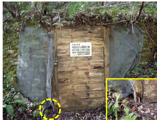
支障箇所 の状況(11月) AR-6(ダムサイト右岸)
