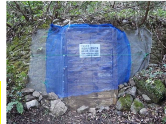
修復後の状況(11月)
