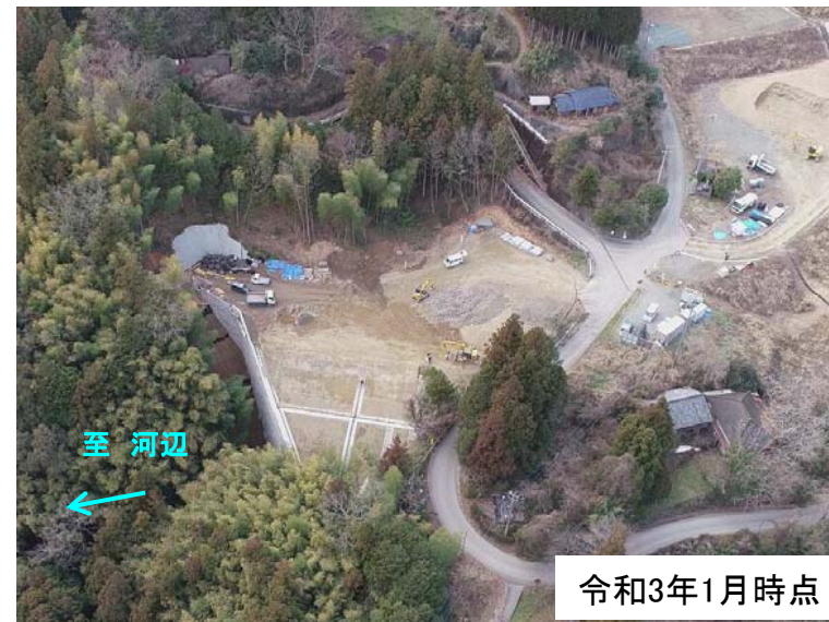
付替県道工事(敷水地区)
