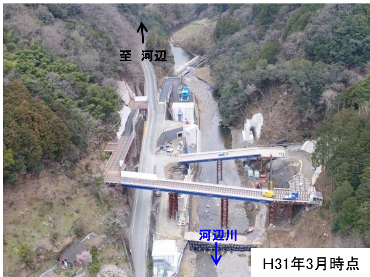
付替県道工事(上鹿野川地区)
