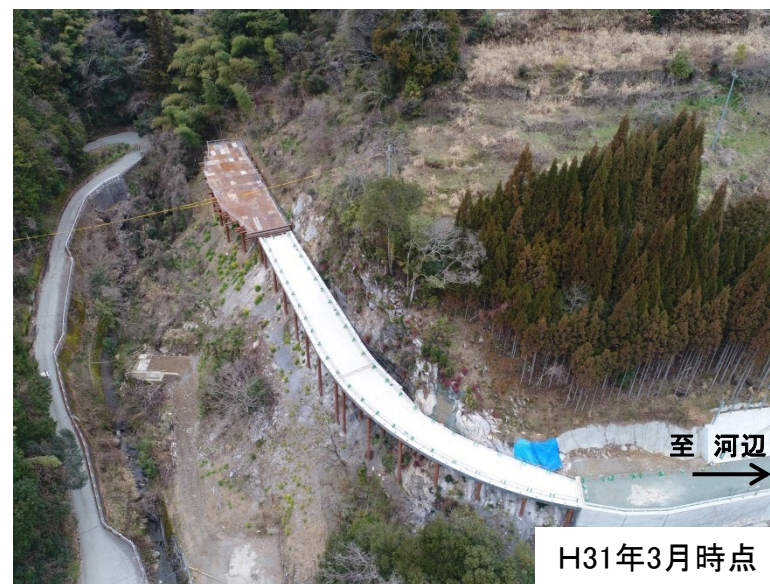
工事用道路工事(下敷水地区)
