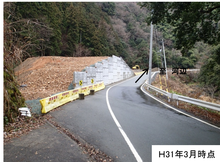
付替県道工事(椽の木瀬地区)
