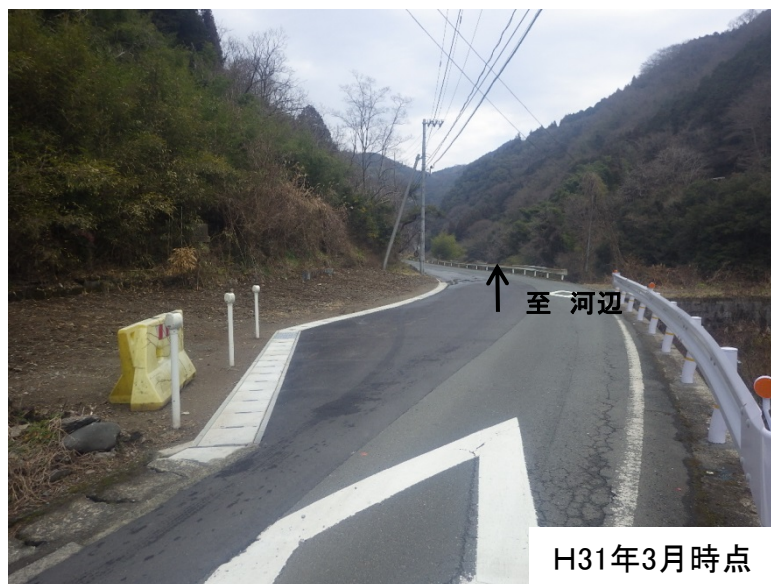
現道部分拡幅(岩谷地区)
