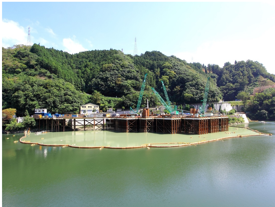
汚濁防止フェンスの設置
