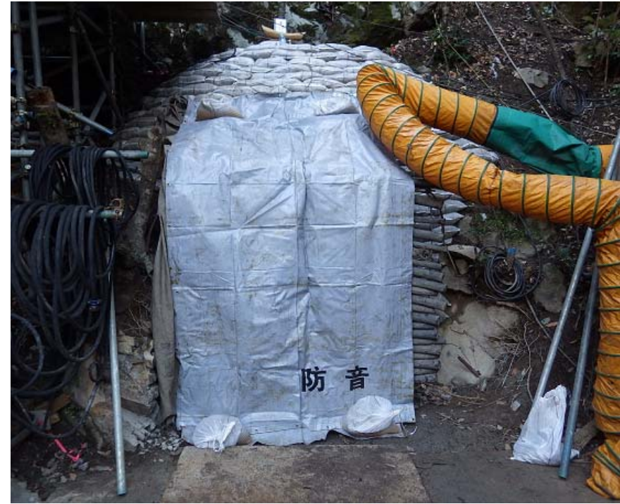
防音シート設置状況
