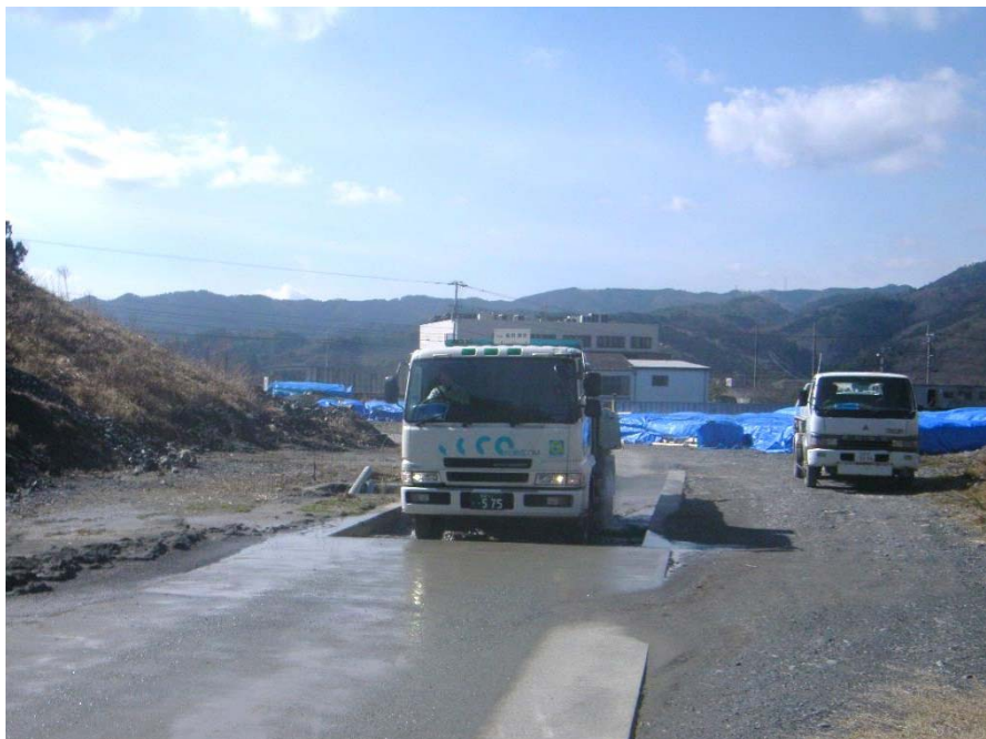
(a) 工事用車両のタイヤ洗浄
