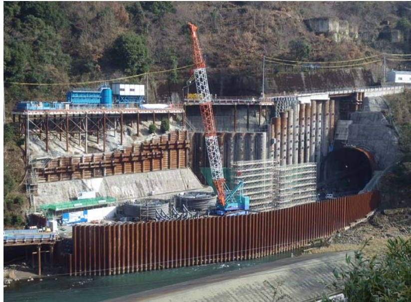
トンネル洪水吐 吐口付近 (1月13日現在)
