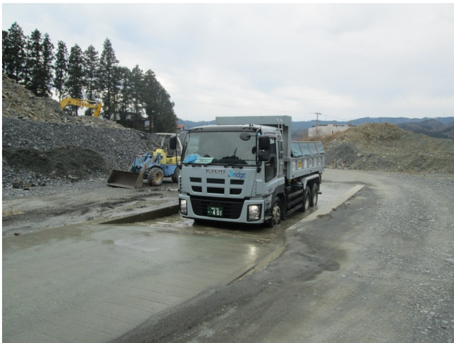
(a) 工事用車両のタイヤ洗浄
