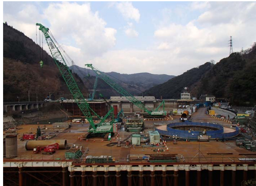
トンネル洪水吐 呑口付近 (1月13日現在)
