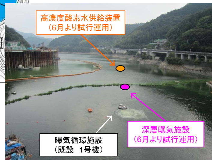
(ダム堰堤から見た各施設に位置関係)
