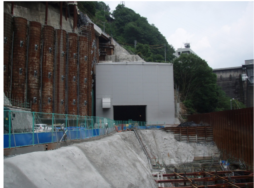
(d)防音ハウス・防音扉(2枚)の設置
