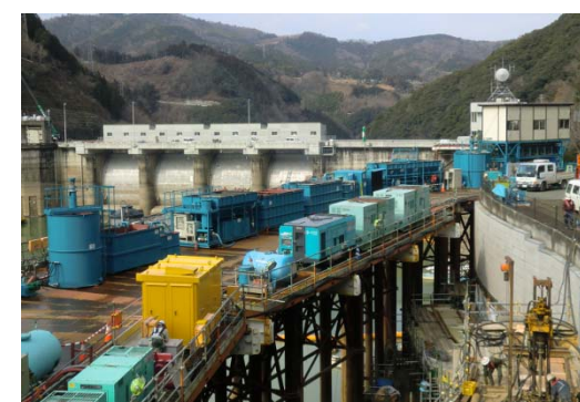
濁水処理装置
