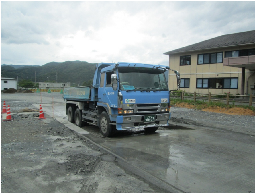
(a) 工事用車両のタイヤ洗浄
