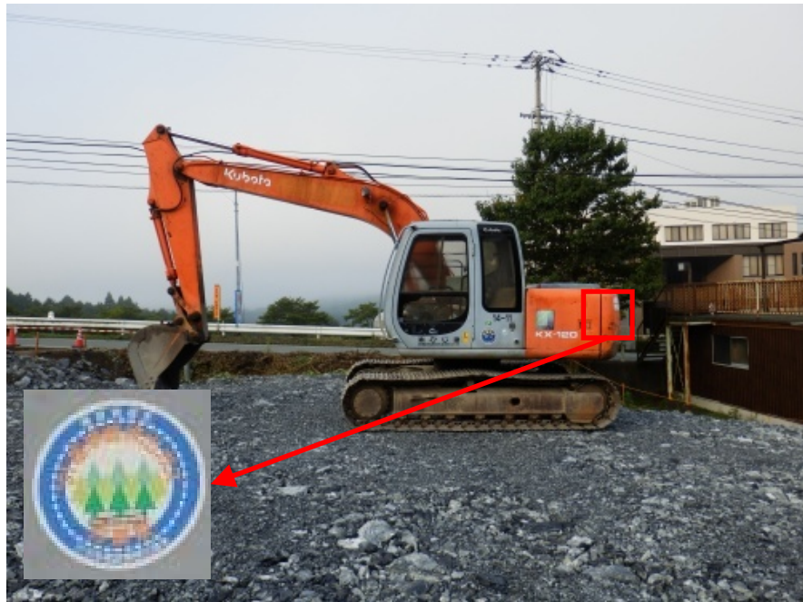
(c)排出ガス対策型建設機械の使用
