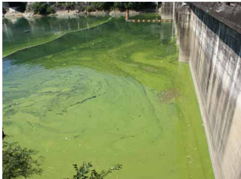
<鹿野川ダムのアオコ発生状況>
