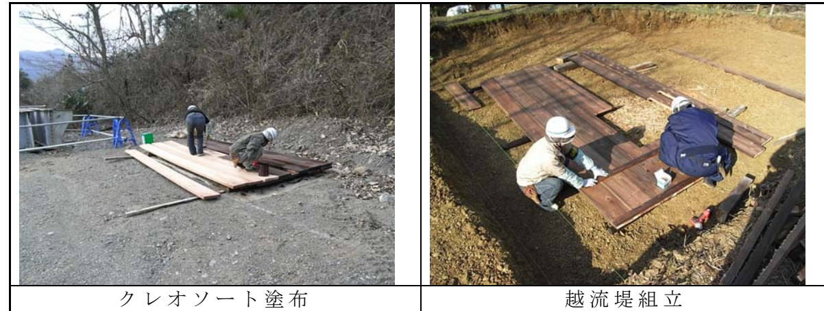
写真 3-5 コシロネ・ホシクサ移植用圃場 越流堰設置状況
