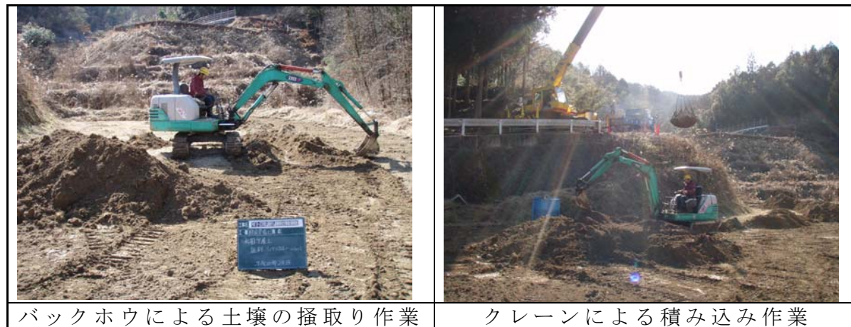
写真 3-2 コシロネ・ホシクサ移植用圃場 水田土掘削・運搬状況
