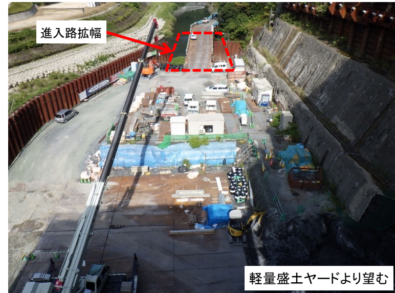
9月11日 工事用進入路の拡幅作業
