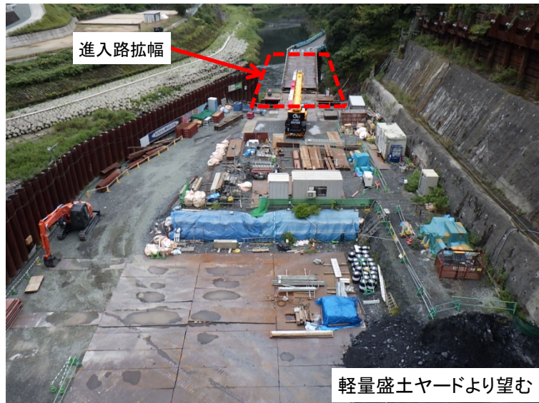
9月18日 工事用進入路の拡幅作業
