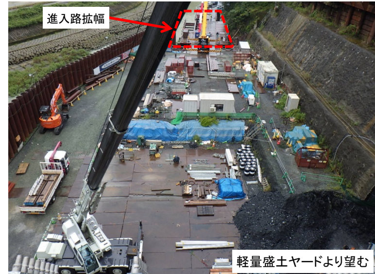
9月25日 工事用進入路の拡幅作業
