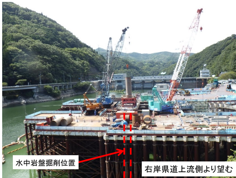
9月4日 掘削機による水中岩盤掘削作業
