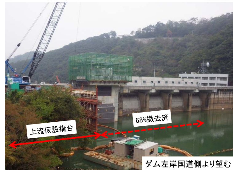
10月24日 上流仮設構台撤去(68%完了)
