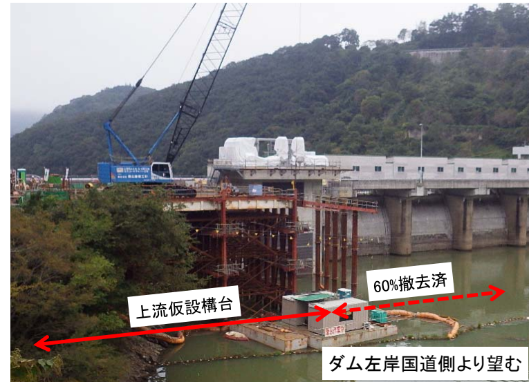
10月10日 上流仮設構台撤去(60%完了)
