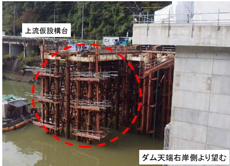
10月3日 上流仮設構台撤去(53%完了)
