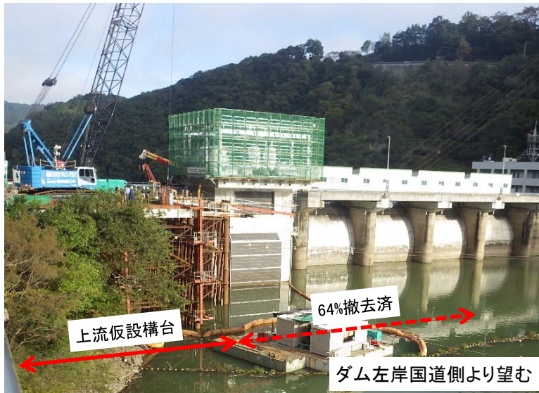
10月17日 上流仮設構台撤去(64%完了)
