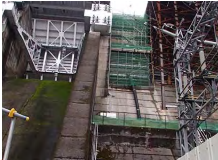
7月1日 予備ゲート室基礎部構築 (8.0m/13.5m)
