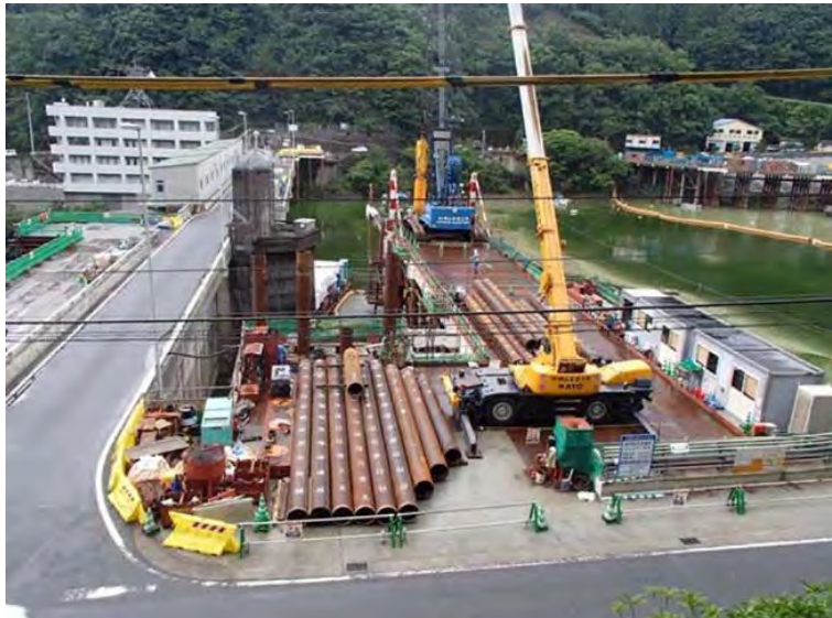
7月1日 仮設構台 5スパン目／全6スパン施工中
