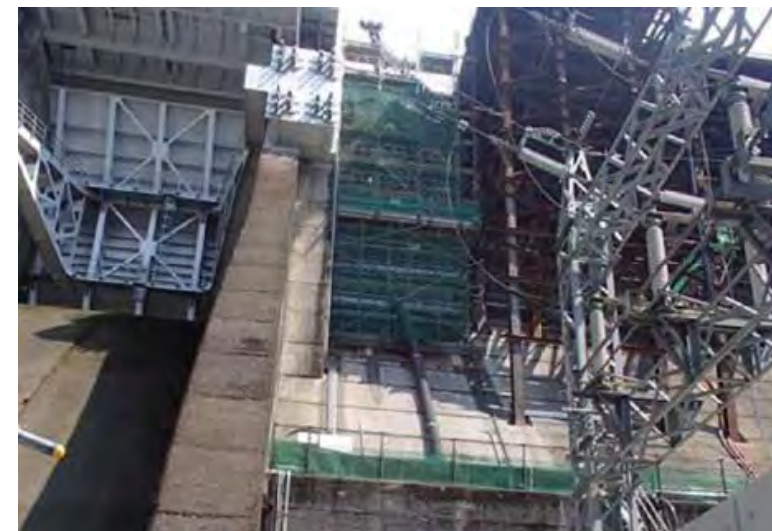
7月22日 予備ゲート室基礎部 構築 (11.0m/13.5)
