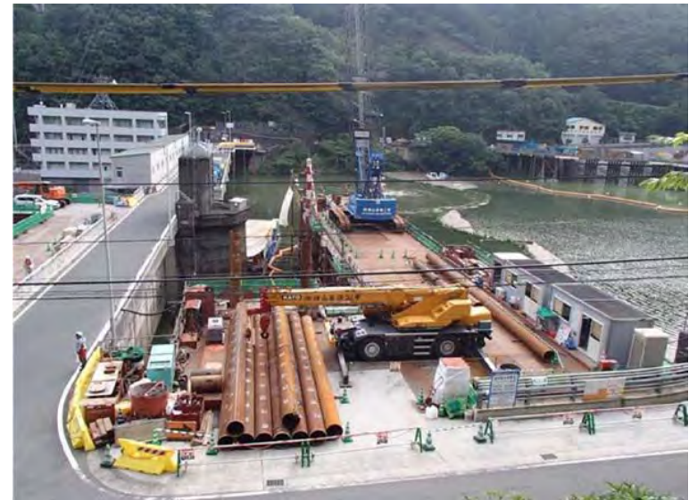
7月8日 仮設構台5スパン目／全6スパン施工中
