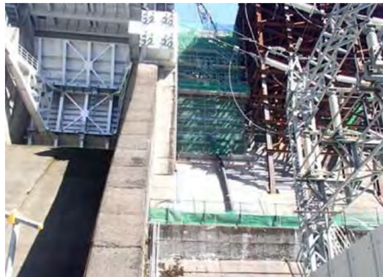
7月15日 予備ゲート室基礎部 構築 8.0m/13.5m)
