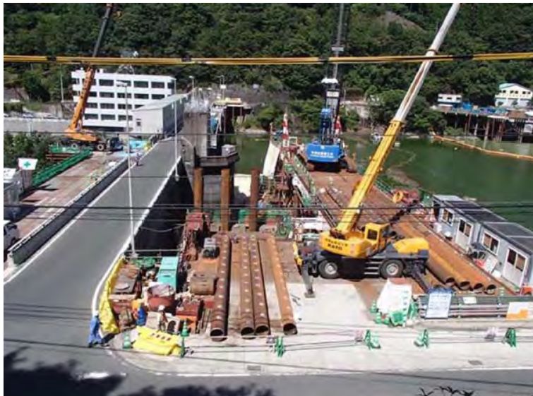
7月15日 仮設構台5スパン目／全6スパン施工中
