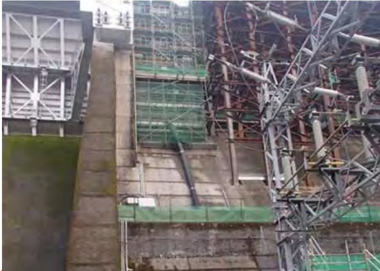
7月29日 予備ゲート室基礎部構築 (11.0m/13.5m)
