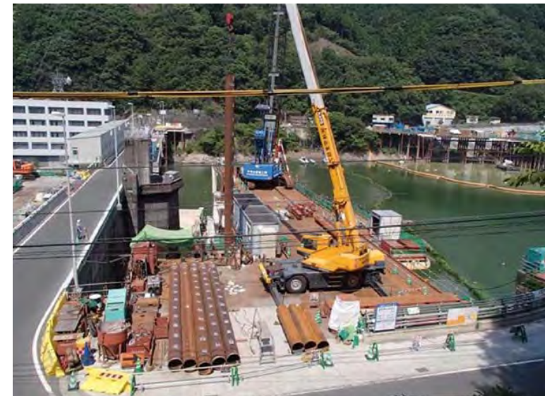
7月22日 仮設構台5スパン目／全6スパン施工中
