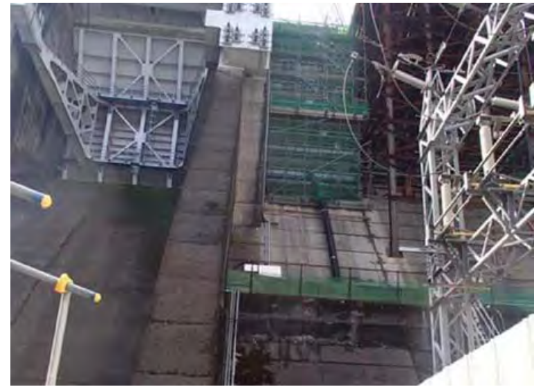
7月8日 予備ゲート室基礎部 構築 8.0m/13.5m)
