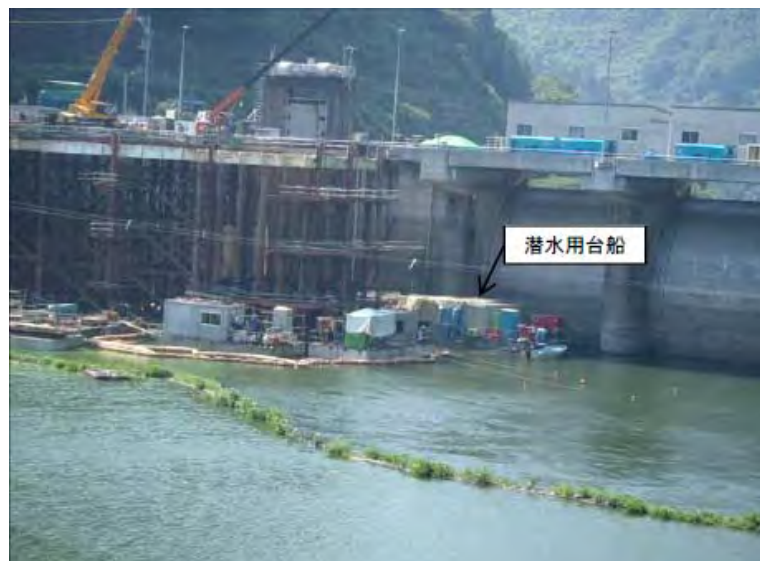
8月19日 低水放流設備準備工 潜水作業
