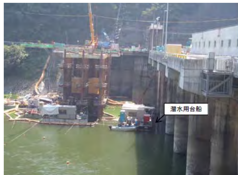
8月12日 低水放流設備準備工 潜水作業
