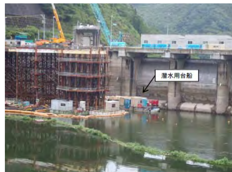
8月26日 低水放流設備準備工 潜水作業
