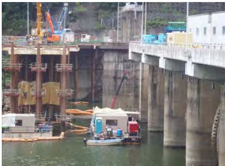
8月5日 低水放流設備準備工 潜水作業
