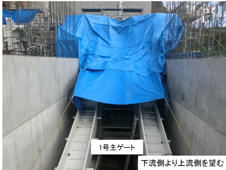
2月20日 主ゲート溶接完了
