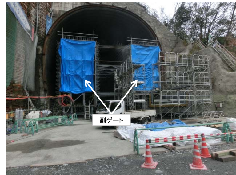
1月25日 分岐管・ベルマウス管溶接・副ゲート据付
