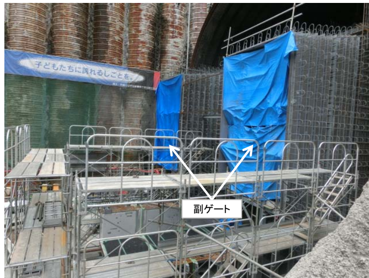
1月18日 分岐管・ベルマウス管溶接・副ゲート据付
