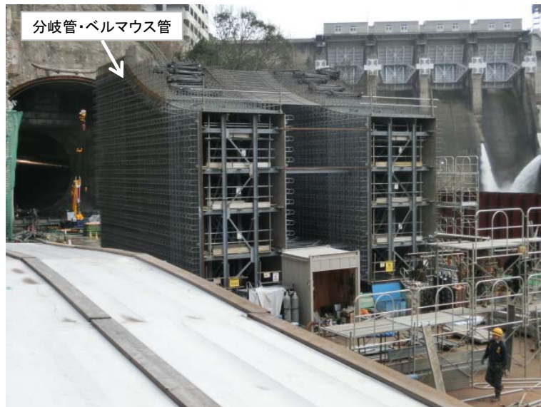
1月4日 分岐管・ベルマウス管 組立・鉄筋溶接
