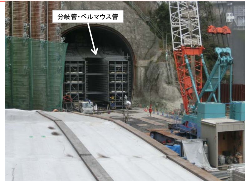
1月11日 分岐管・ベルマウス管の引込
