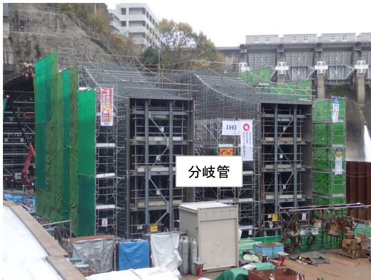
12月7日 分岐管組立・溶接
