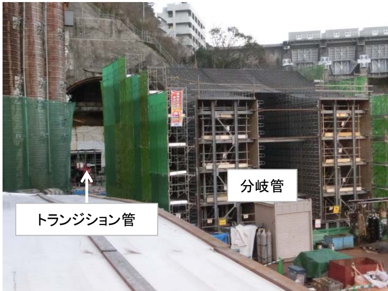
12月21日 トランジション管内部支保工撤去・分岐管鉄筋設置
