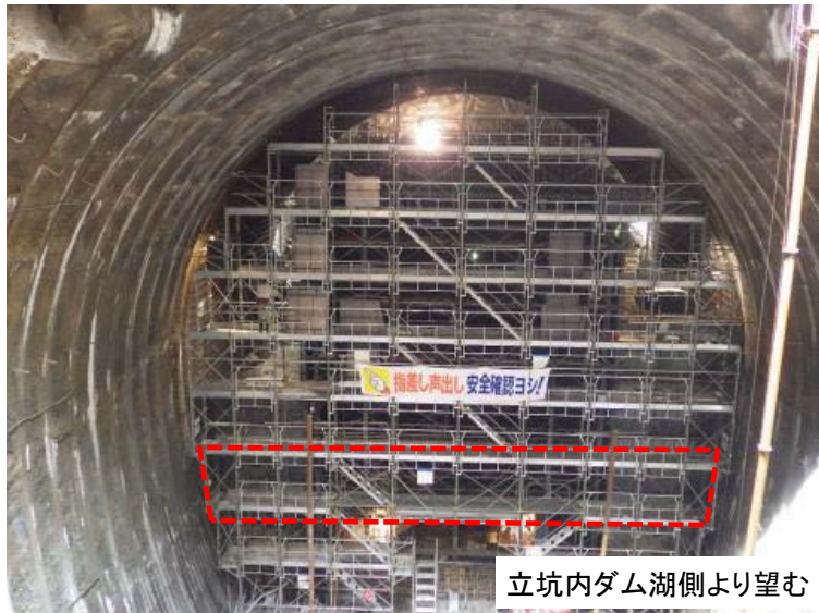
7月4日 コンクリート打設(3リフト目)
