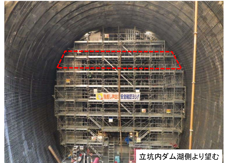
7月25日 コンクリート打設(6リフト目)
