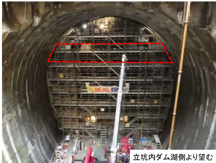
7月18日 鋼製埋設型枠設置(6リフト目)
