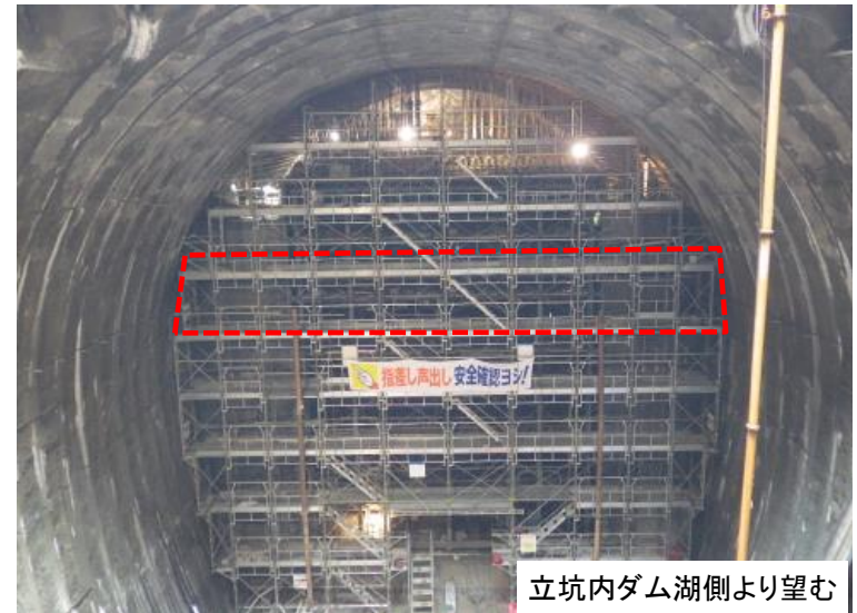
7月11日 鋼製埋設型枠設置(5リフト目)
