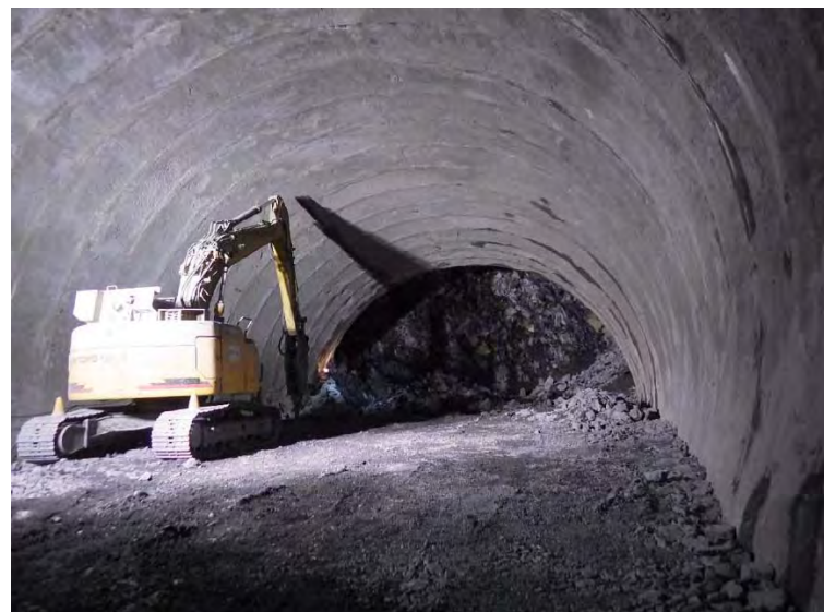
1月13日 上半掘削 437m 下半432m 基礎114m
