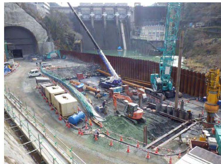
1月27日 鋼管矢板打設、防音ハウス解体完了
