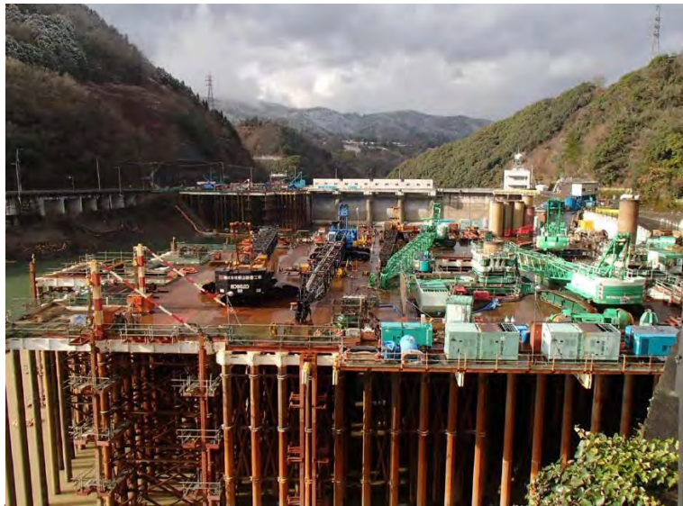
1月6日 仮設構台設置、呑口立坑掘削
