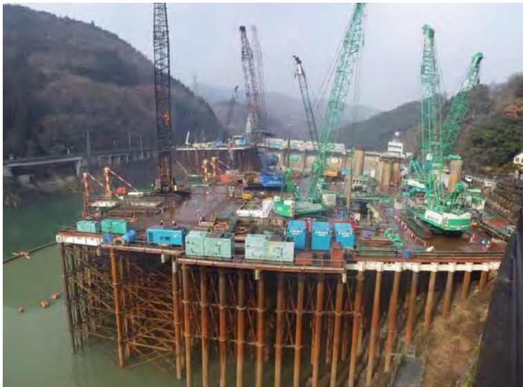
1月20日 仮設構台設置、呑口立坑掘削
