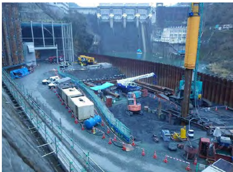
1月20日 鋼管矢板打設、防音ハウス解体
