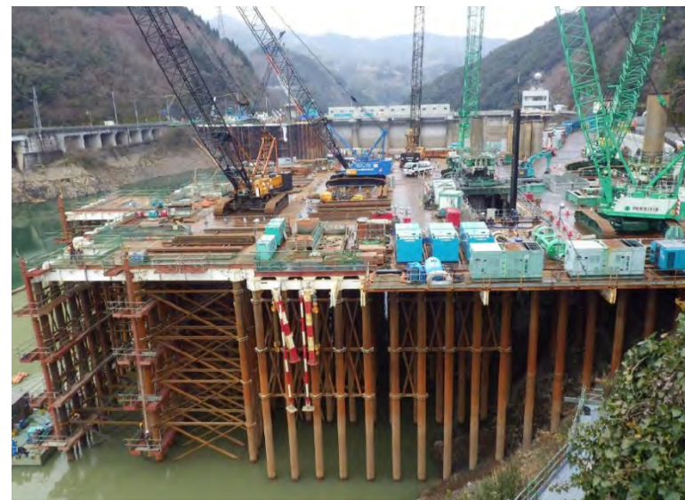
1月13日 仮設構台設置、呑口立坑掘削
