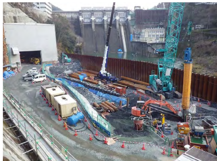
1月13日 鋼管矢板打設
