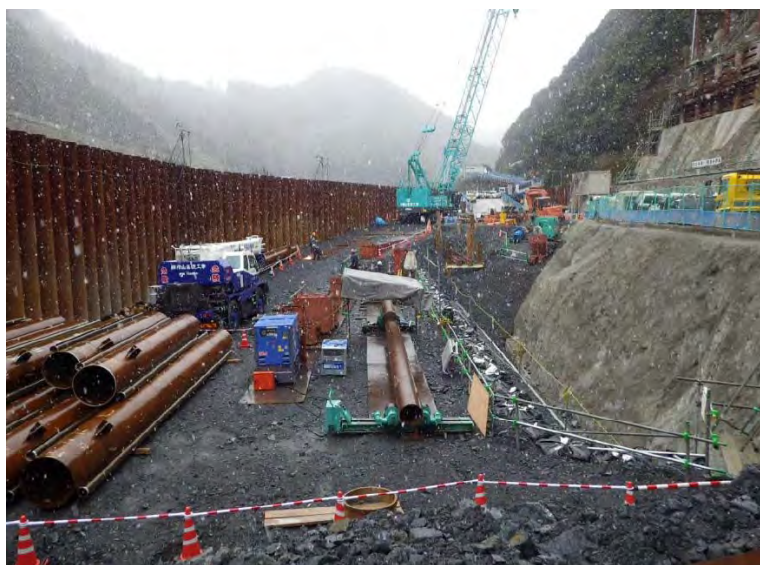
1月6日 鋼管矢板工準備
