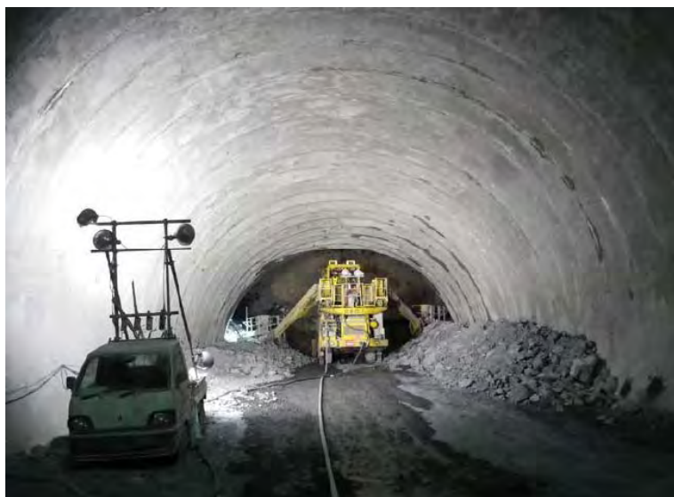
1月20日 上半掘削 441m 下半432m 基礎114m
