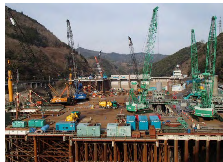
1月27日 仮設構台設置、呑口立坑掘削
