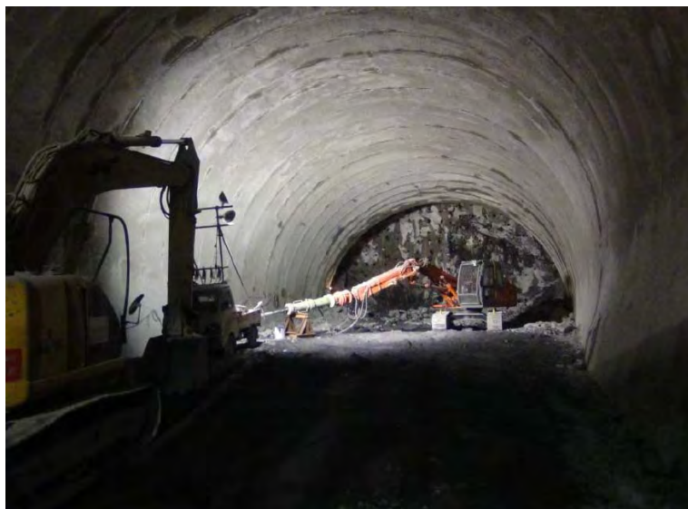
1月6日 上半掘削 436m 下半432m 基礎114m
