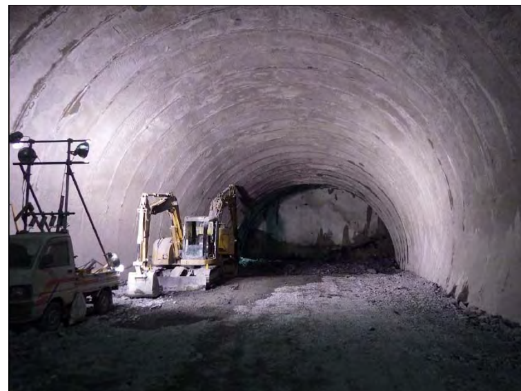
1月27日 上半掘削 443m 下半432m 基礎114m
