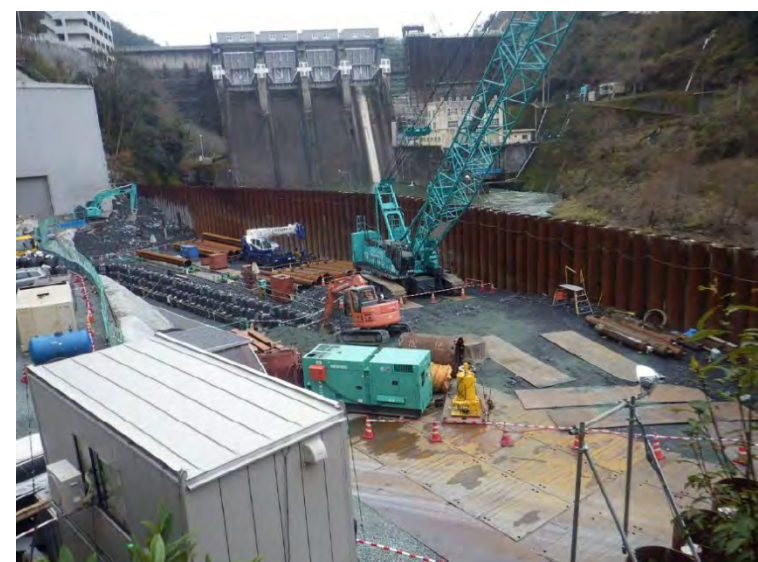
12月23日 鋼管矢板工準備
