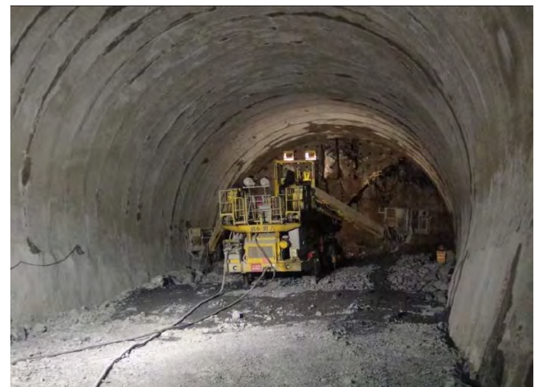
12月9日 上半掘削 433m 下半432m 基礎114m
