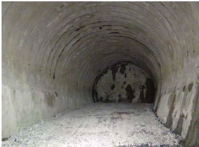
12月2日 上半掘削 433m 下半432m 基礎114m
