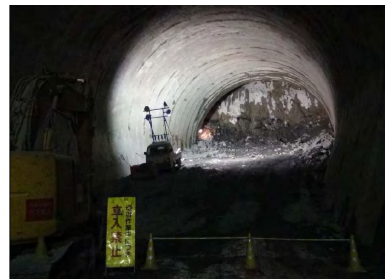
12月23日 上半掘削 435m 下半432m 基礎114m
