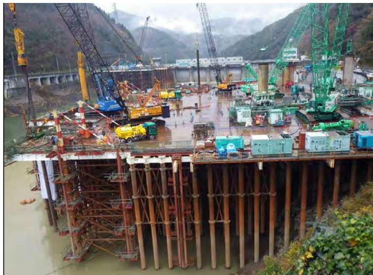
12月16日 仮設構台設置、呑口立坑掘削
