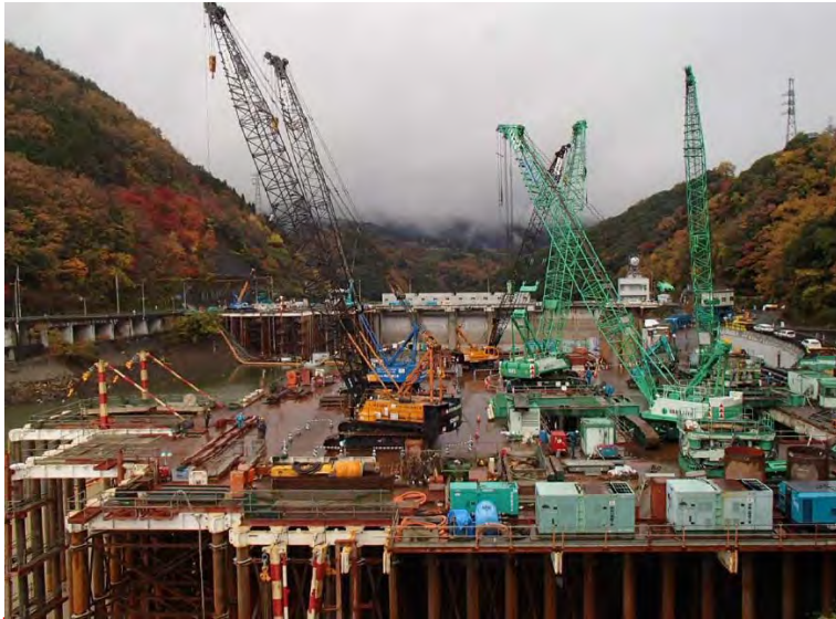
12月2日 仮設構台設置、呑口立坑掘削
