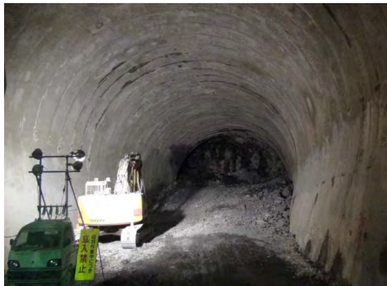
12月16日 上半掘削 434m 下半432m 基礎114m
