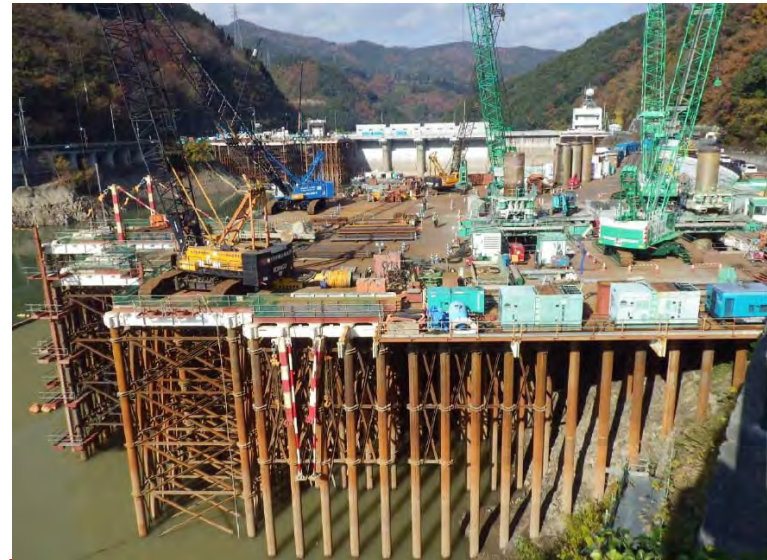
12月9日 仮設構台設置、呑口立坑掘削
