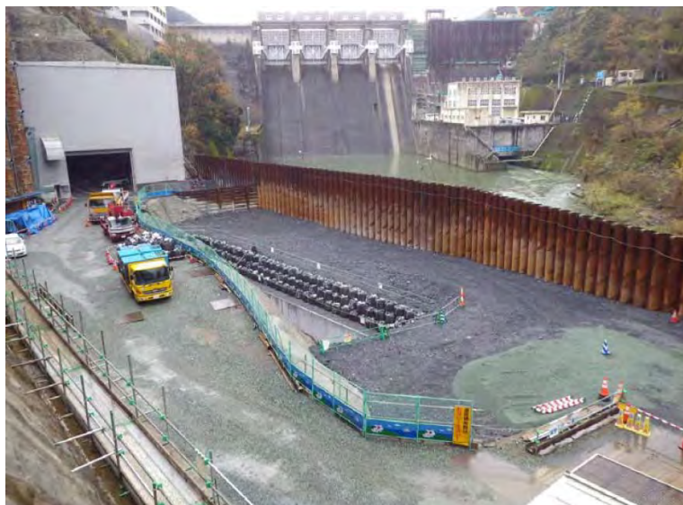
12月16日 埋戻完了、鋼管矢板工準備
