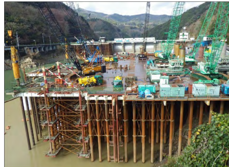
12月23日 仮設構台設置、呑口立坑掘削
