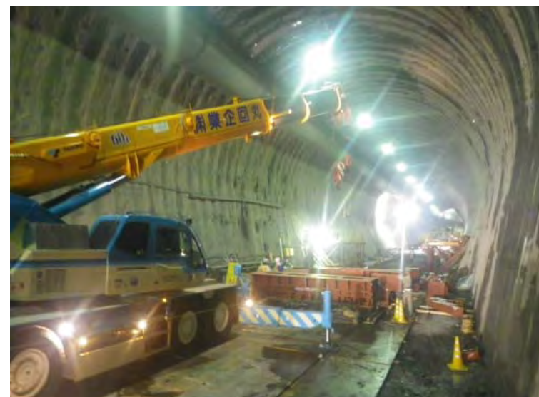
9月23日 上半掘削 355m 下半308m 基礎114m
