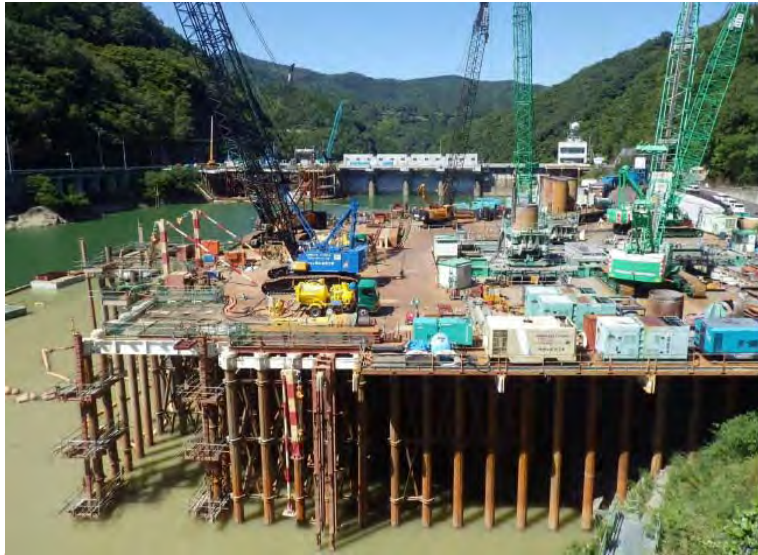
9月30日 仮設構台設置、呑口立坑掘削
