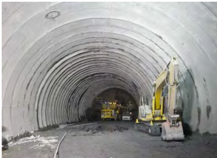
9月2日 上半掘削 341m 下半246m 基礎114m
