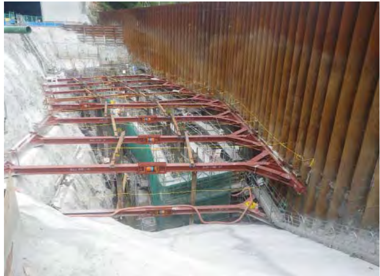
9月23日 鉄筋組立、コンクリート打設
