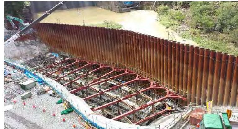
9月9日 鉄筋組立、コンクリート打設
