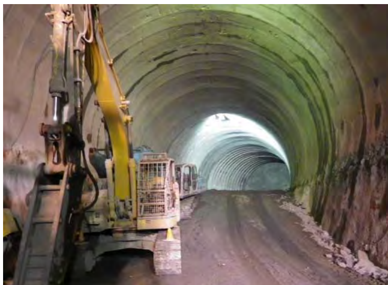
9月16日 上半掘削 355m 下半308m 基礎114m
