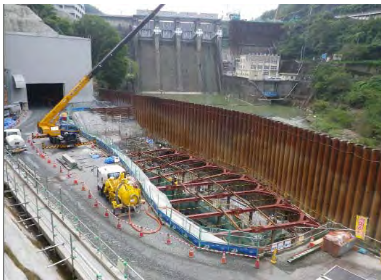
9月16日 鉄筋組立、コンクリート打設
