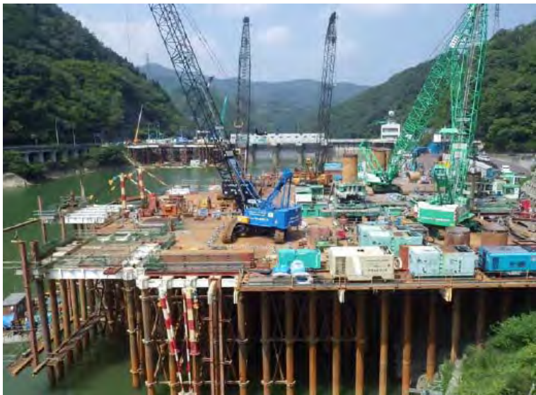
9月16日 仮設構台設置、呑口立坑掘削
