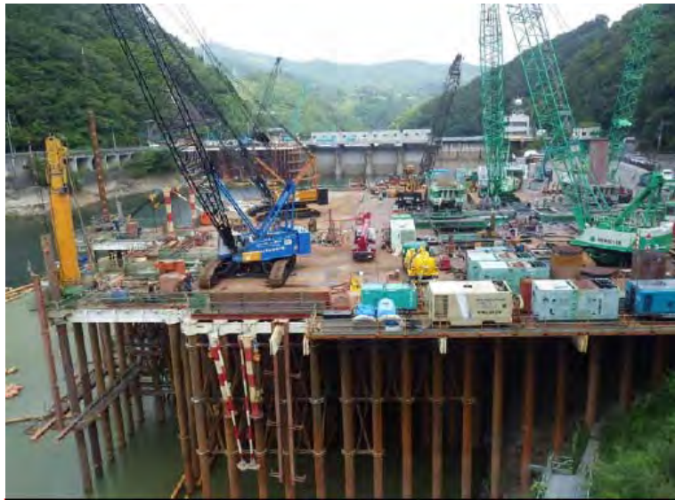
9月2日 仮設構台設置、呑口立坑掘削
