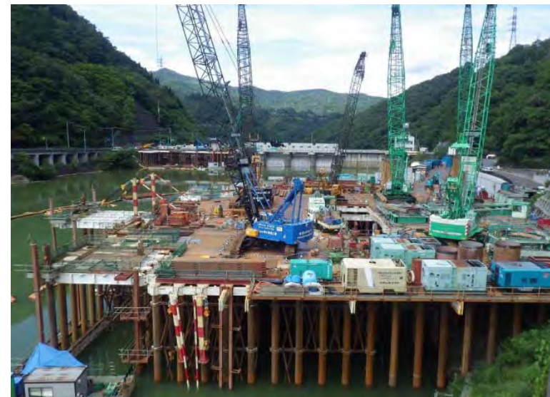
9月9日 仮設構台設置、呑口立坑掘削
