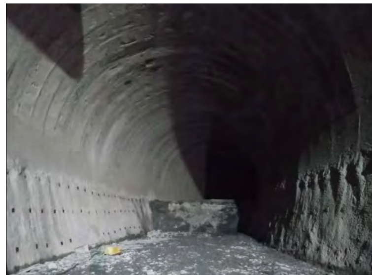
9月9日 上半掘削 346m 下半274m 基礎114m
