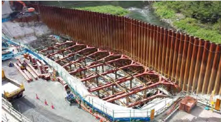
9月2日 鉄筋組立、コンクリート打設
