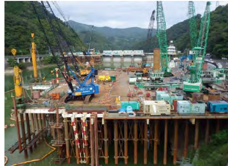
9月23日 仮設構台設置、呑口立坑掘削
