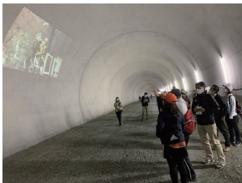
トンネルの中で工事紹介
