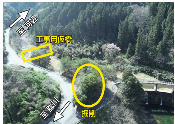
新岩谷橋（付替道路工事）
