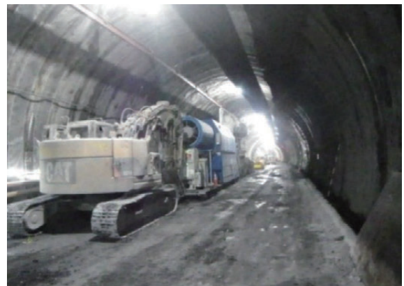
敷水トンネル（付替道路工事）
