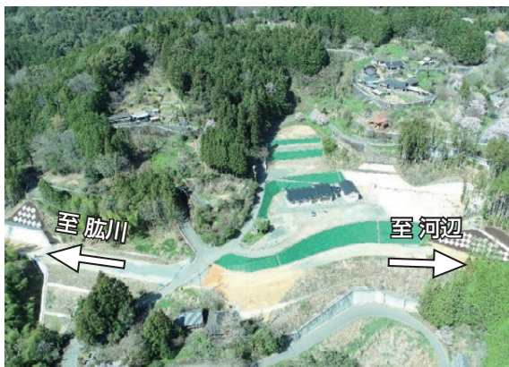
敷水地区（付替道路工事）
