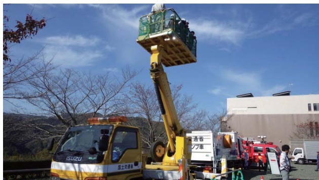
トンネル点検車の乗車体験の様子
