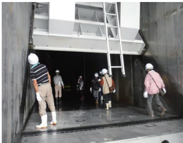
トンネル洪水吐内に主ゲートをくぐって進入
