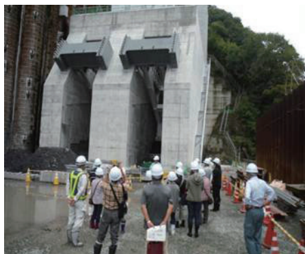
吐口部での工事概要説明
