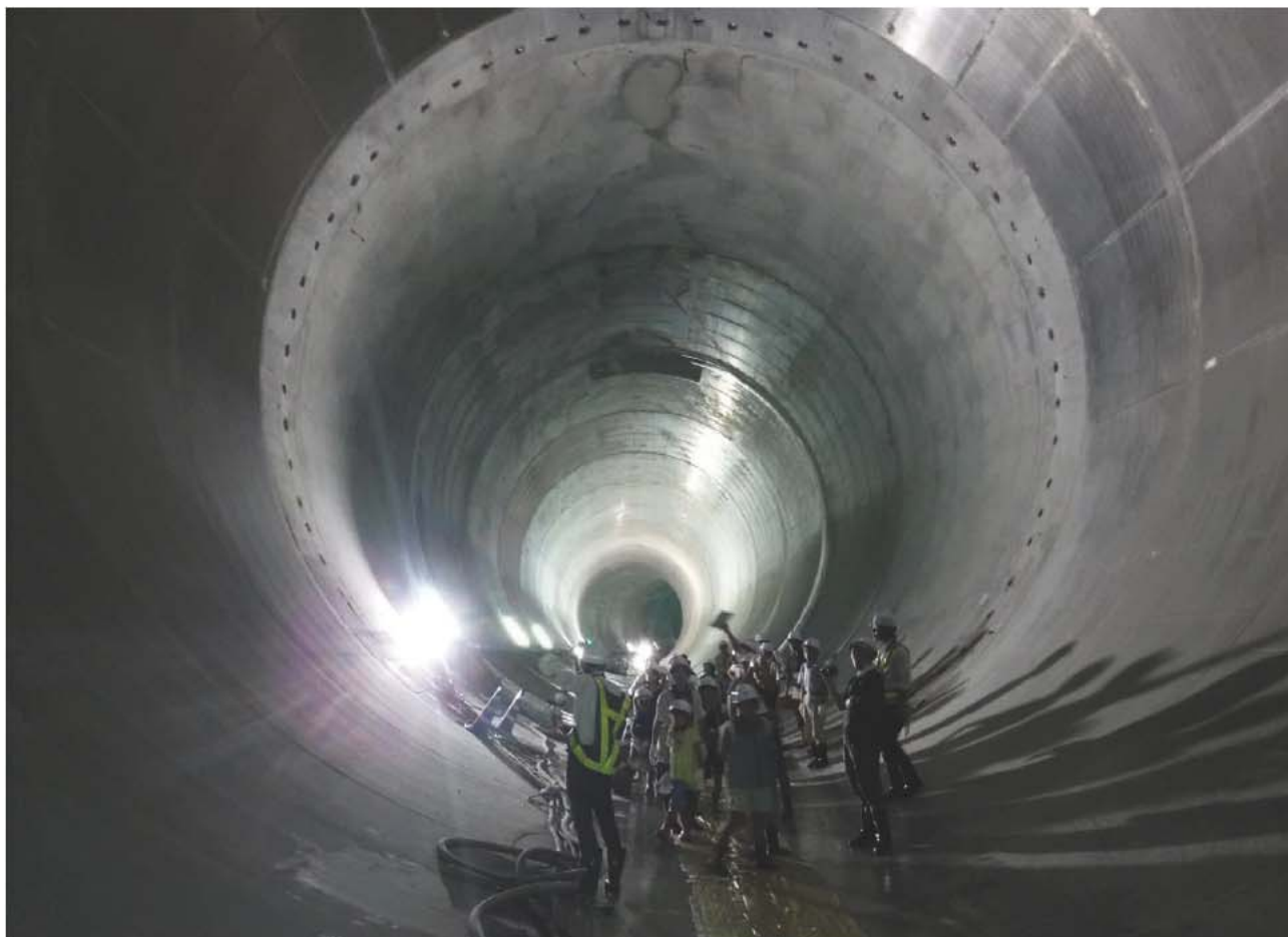
鹿野川ダムトンネル洪水吐内部（平成 28 年 8 月 28 日夏休み見学会）
