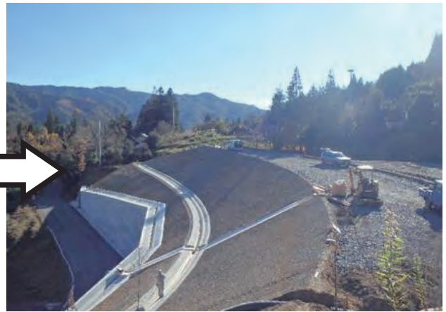
敷水地区（付替県道） 現在の状況
