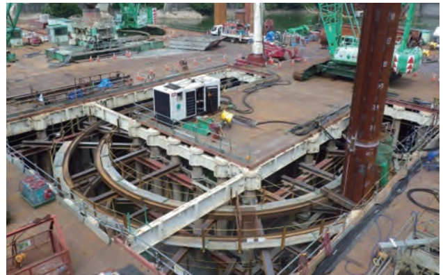
⑯鋼管矢板の打ち込みを開始しました (H26.7)
