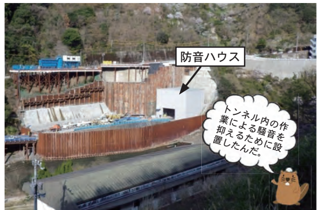
④トンネルの出口に防音ハウスを設置しました (H25.2)
