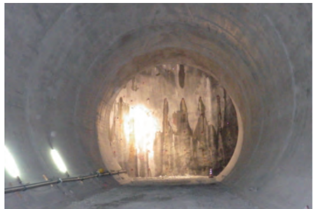
⑩コンクリートの覆工が終わりました (H26.11)
