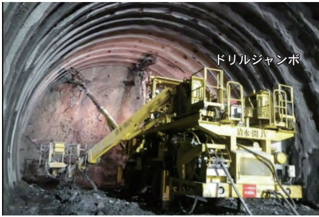
⑤岩盤に孔を空けて発破の火薬を仕掛けます (H25.4)
