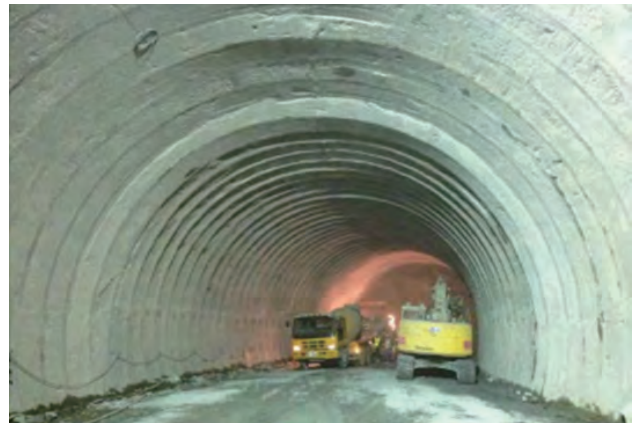
⑥全長 457mのうち 380mまで掘削が進んでいます (H25.10)
