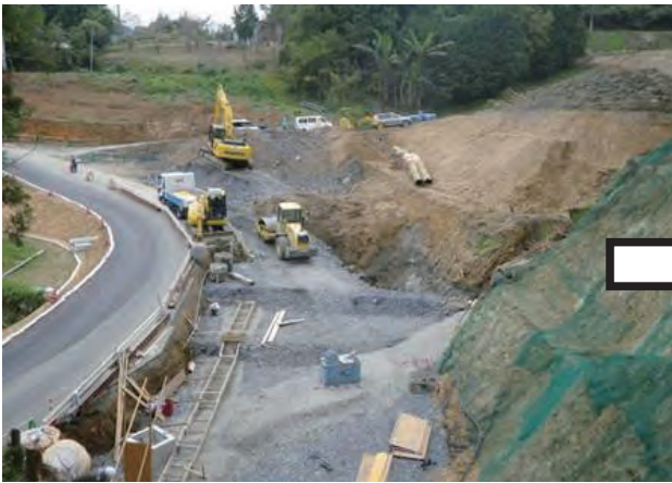
敷水地区（付替県道） 施工状況
