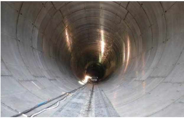
⑬鉄管の溶接後に内部の支保工を撤去しました (H27.8)
