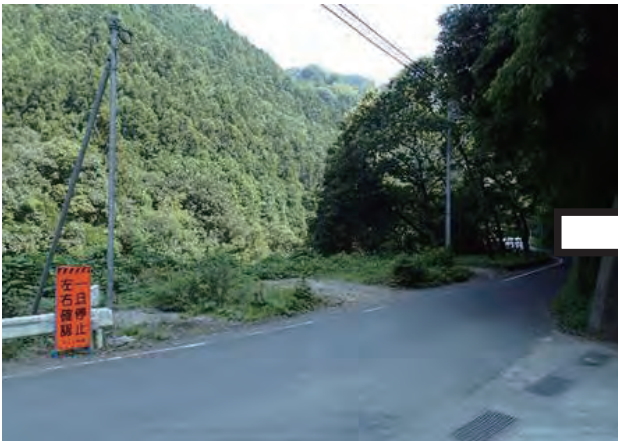
下敷水地区 県道待避所 施工前
