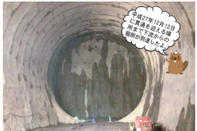
⑧貫通地点（出口から 443m）まで掘削が到達しました (H26.3)
