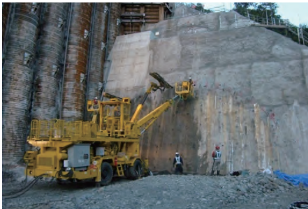
①吐口（下流）側から掘削を開始しました (H24.10)
