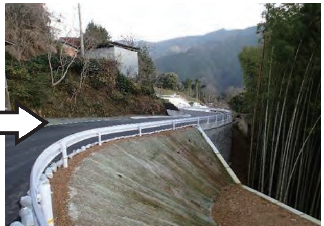
見の越地区（工事用道路） 現在の状況
