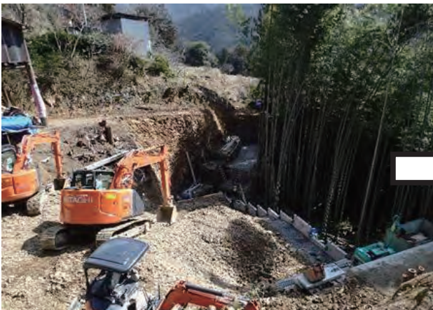
見の越地区（工事用道路） 施工状況
