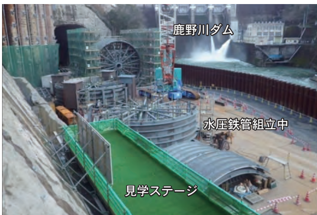
⑪トンネル下流側に設置する水圧鉄管を組み立てます (H27.2)
