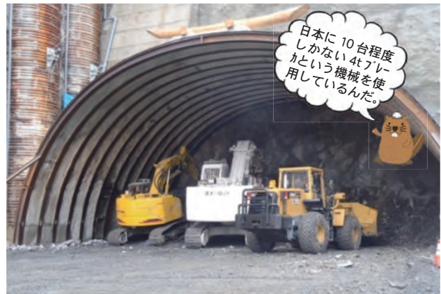
②トンネル断面の上の方から掘削を行っています (H24.12)
