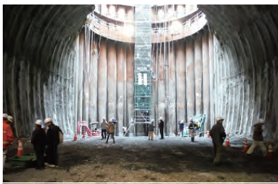
㉔洪水吐トンネル立坑内(H28.2)
