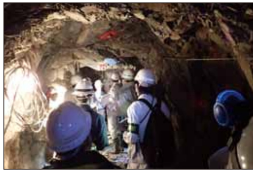
横坑調査での岩盤分析
