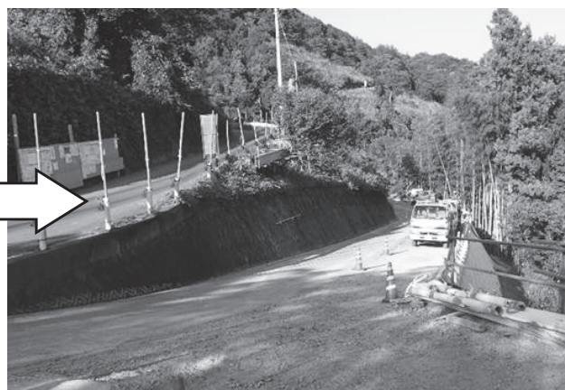
見の越地区 施工中
