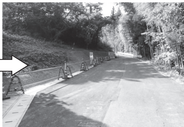
菟野尾地区 施工中
