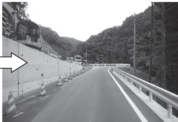
下敷水地区 施工中
