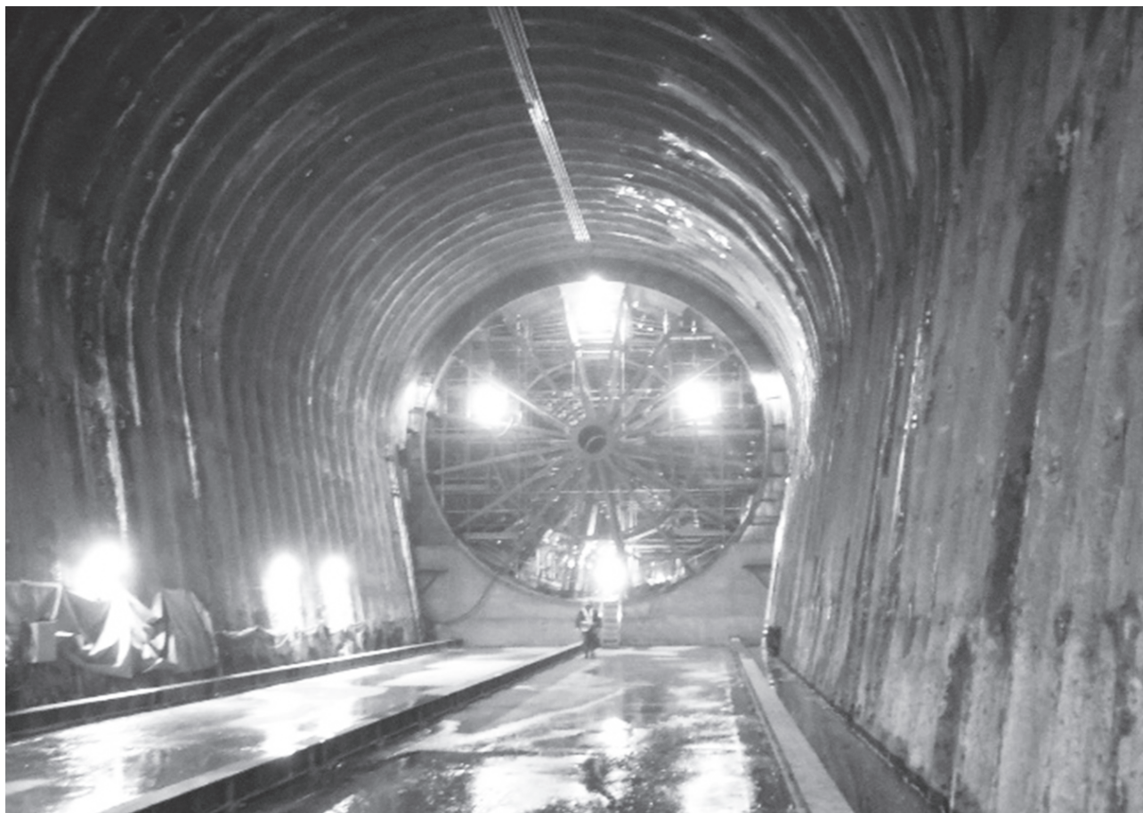
水路トンネルの内部(施工風景)
