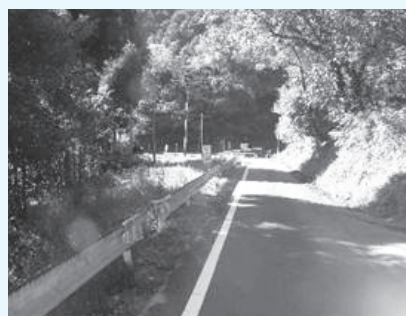
現県道の部分 拡幅工事
