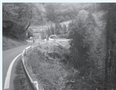
樹木伐採による 見通しの改善
