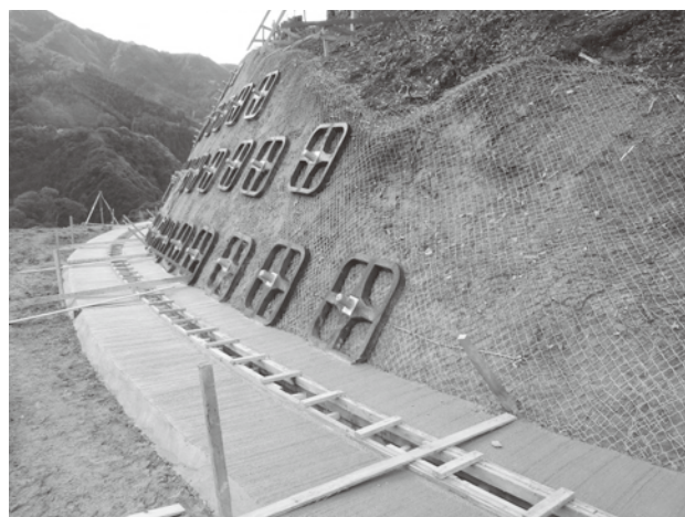
下敷水地区（付替県道）
