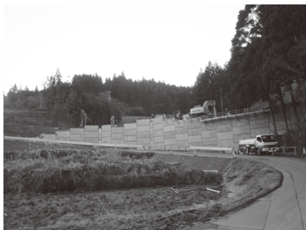
敷水地区（公共施設移転先付近）
