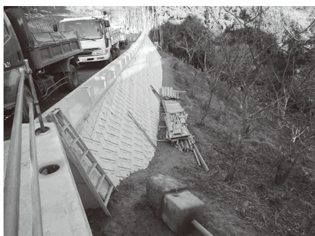
見の越地区（工事用道路）
