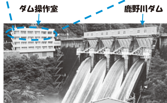
鹿野川ダム操作室は鹿野川ダム管理庁舎にあります。
