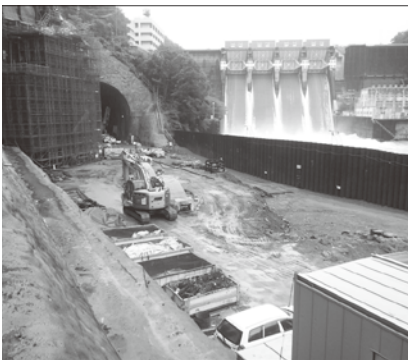
トンネル吐口部(下流側切土面より)
