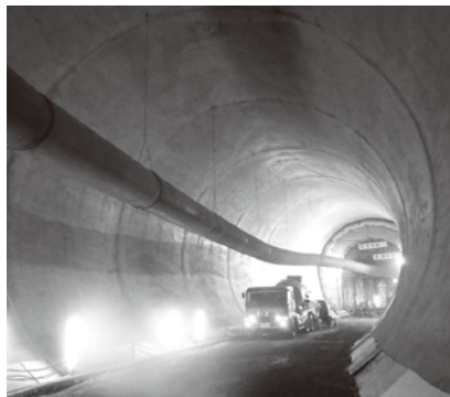
トンネル内部覆工コンクリート打設
