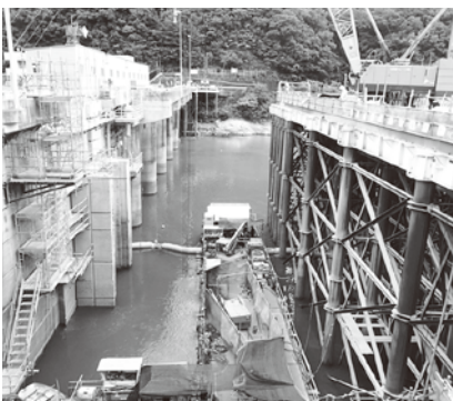
ダム湖側既設取水塔撤去状況
