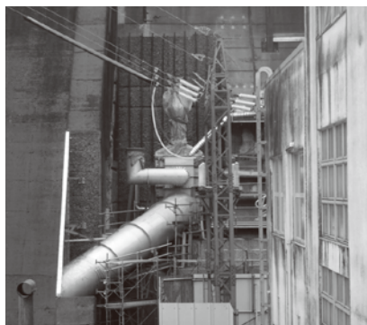
ダム下流面低水放流管(コンクリート打設前)
