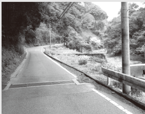
現県道の部分 拡幅工事
