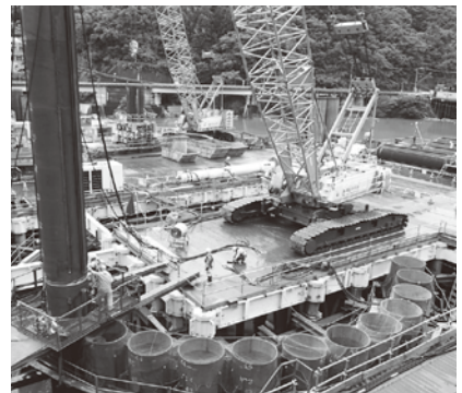
呑口立坑外周・鋼管矢板打込み状況
