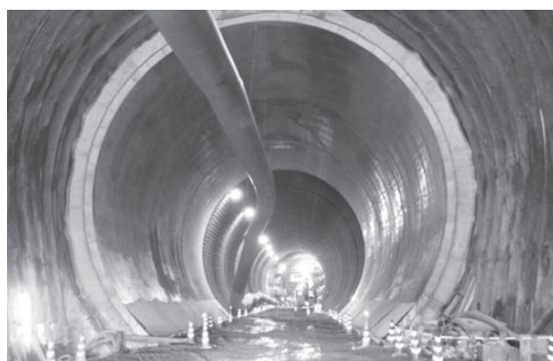
トンネル内部覆工コンクリート打設
