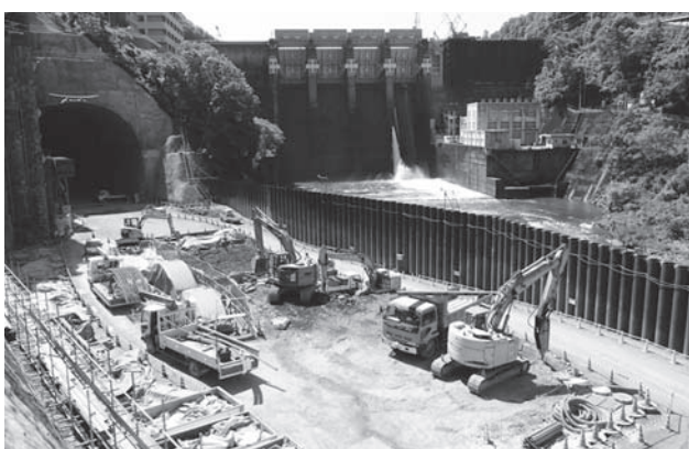
トンネル吐口部(下流側切土面より)
