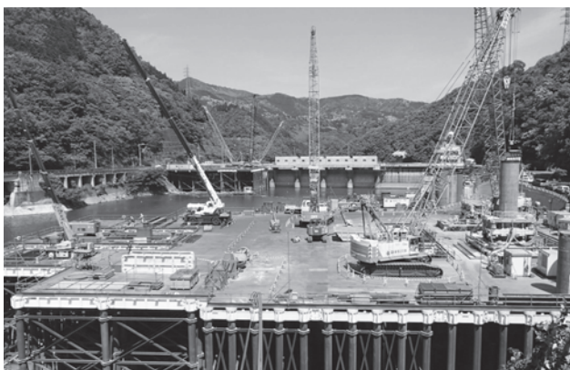
呑口立坑・鋼管杭建込部掘削状況
