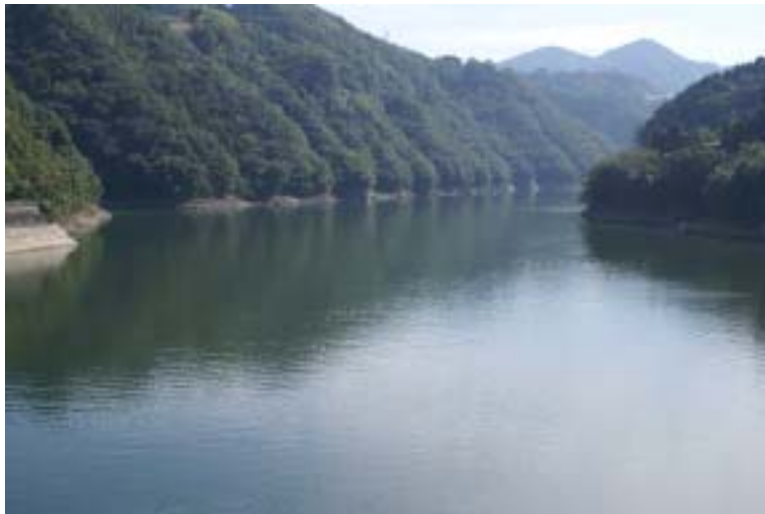
鹿野川ダム貯水池
