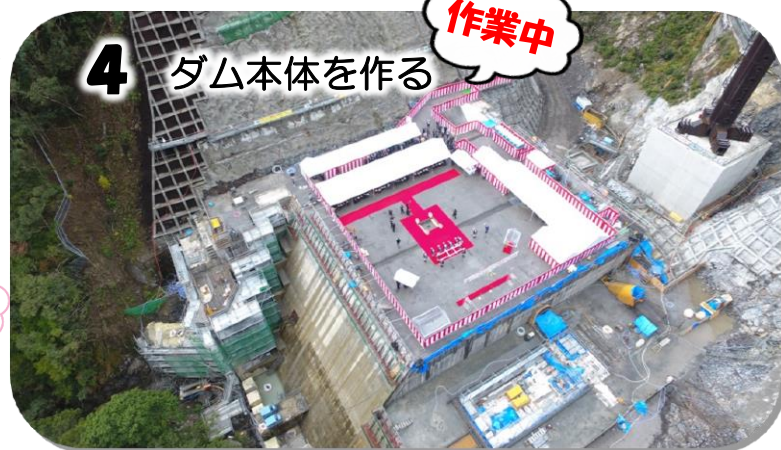
2017年12月3日 現場の状況(主な作業:本体コンクリート打設)
