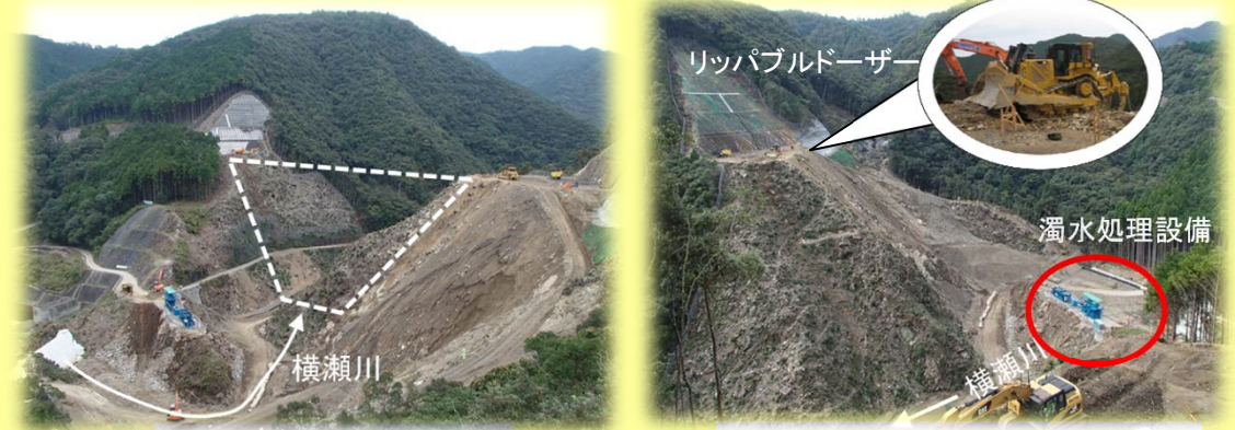
ダムサイト左岸
