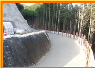
付替市道工事状況 (平成25年5月撮影)
