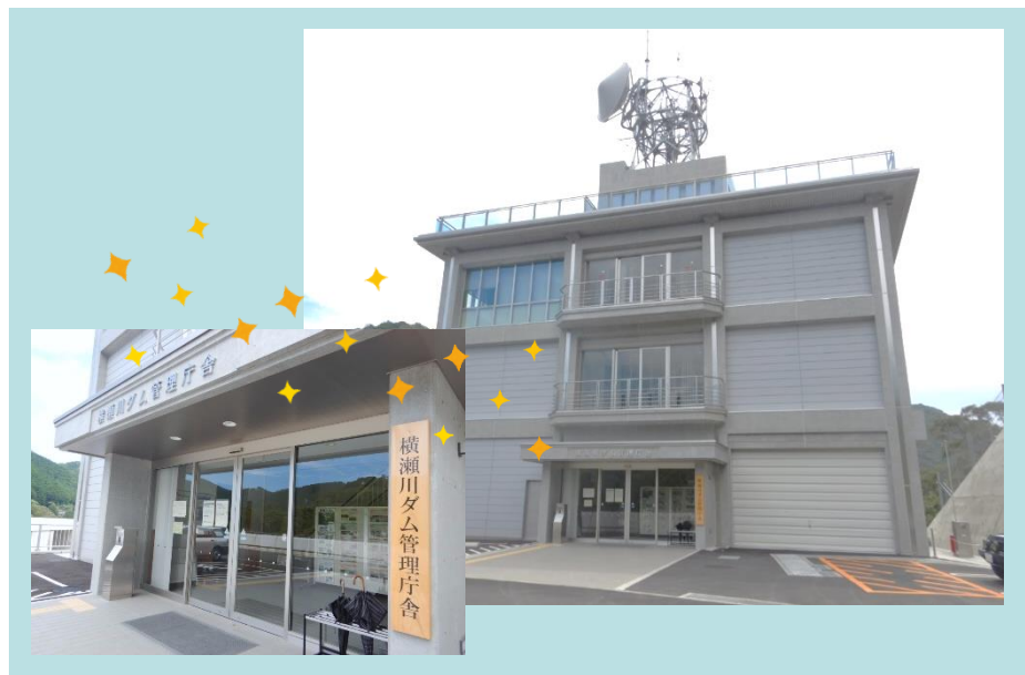
横瀬川ダム管理庁舎
