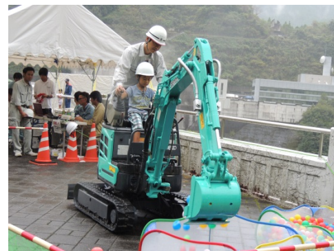
建設業協会幡多支部連合会のミニバックホウ乗車体験
