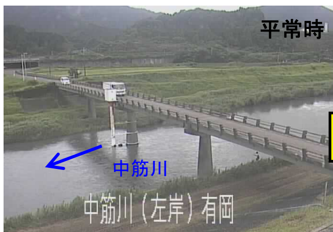
洪水前後の水位の変化(中筋川磯ノ川地点)
