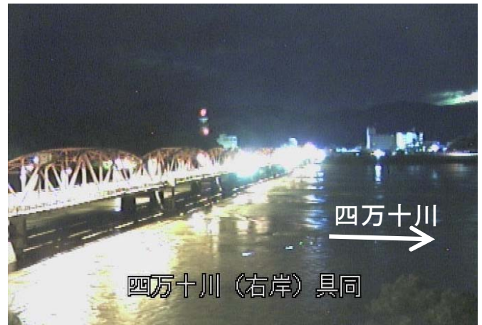
洪水ピーク時の状況(四万十川橋)
