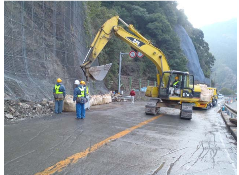
【大型土嚢設置】
