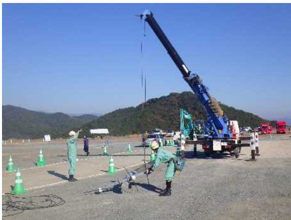
倒壊電柱撤去
