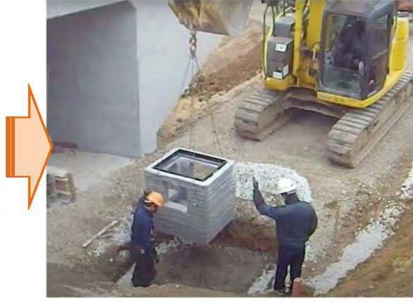
集水枡の設置状況
