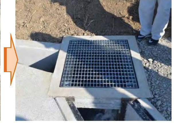
設置された集水枡
