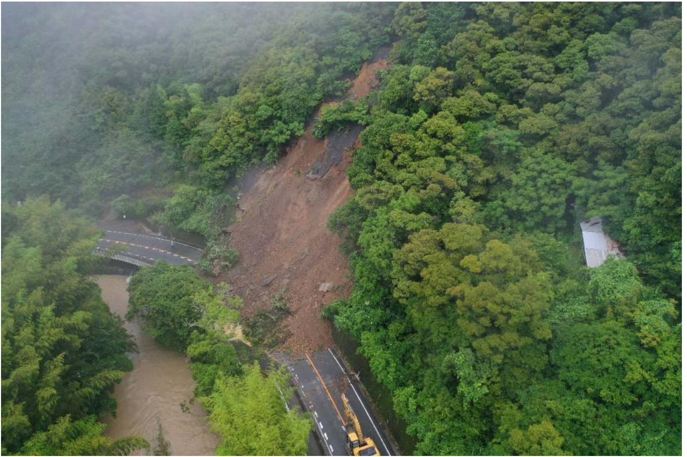
被災状況(2022. 7. 5 AM10時頃)
