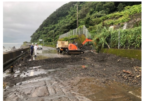
土砂撤去作業
