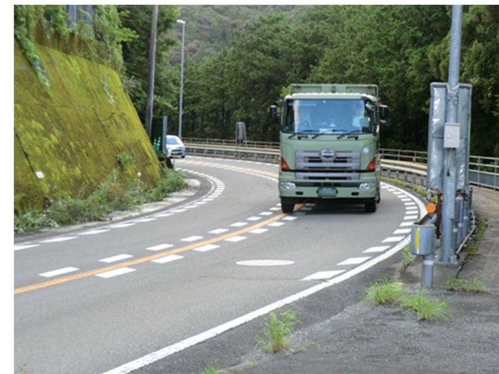
写真① 平面線形不良区間
