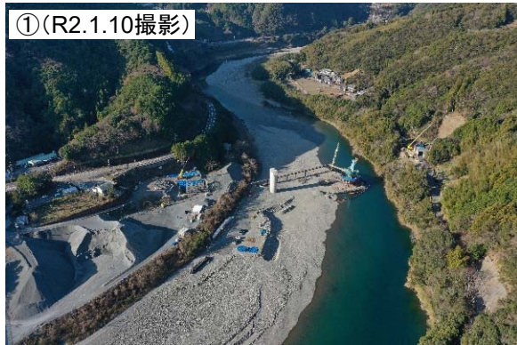
▲新横倉橋下部工施工状況
