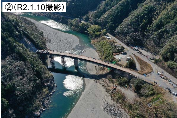
▲立花大橋上部工施工状況
