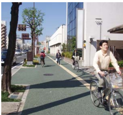
現況の様子 (国道32号)
