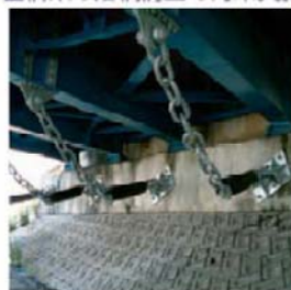
●橋桁と橋脚を連結
