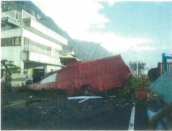
平成16年台風23号越波で倒壊した家屋と越波と共に打ち上げられた石
