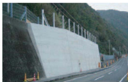
●復旧後(H16完了)
