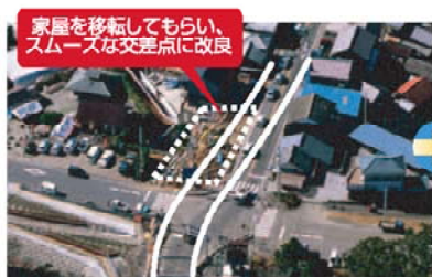
●仁淀川橋交差点の整備前
