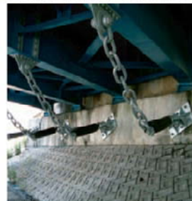
● 橋桁と橋脚を連結
