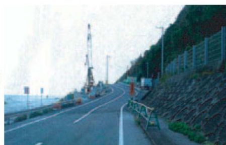
●仮復旧(H18年度も引き続き復旧工事実施中)
