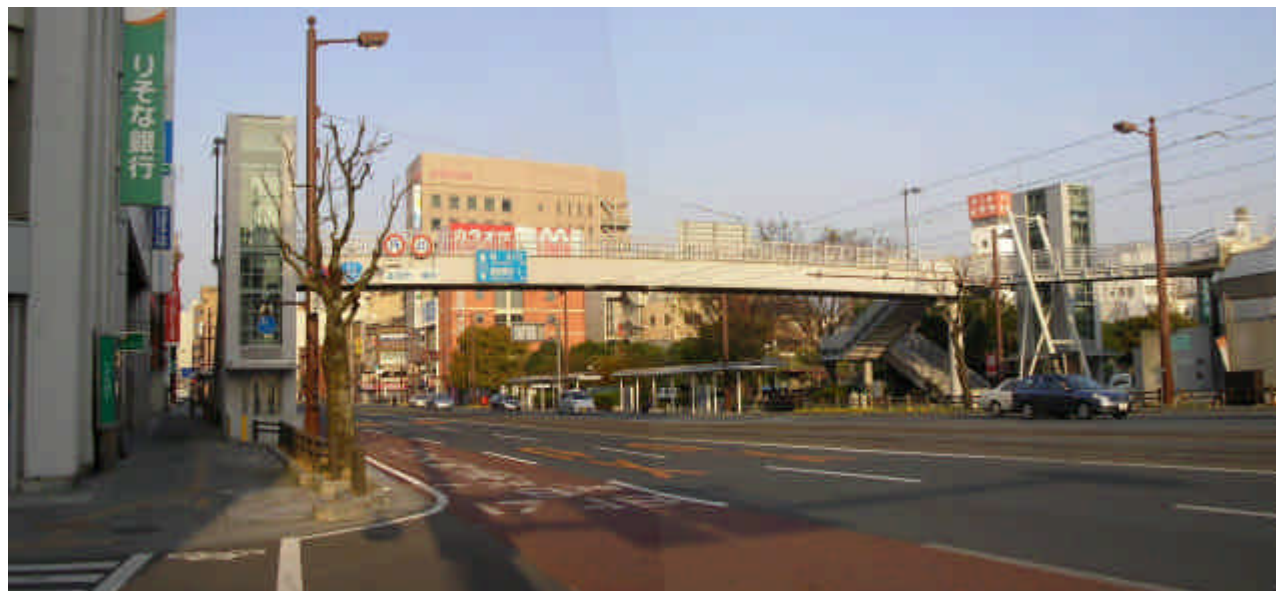
完成写真（平成18年3月28日撮影）
